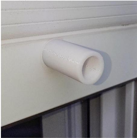
10. Colocar maneta de agarre de cordón. Sacar tornillos, quitar carcasa, pasar cordón entre frenos, volver a ensamblar.
